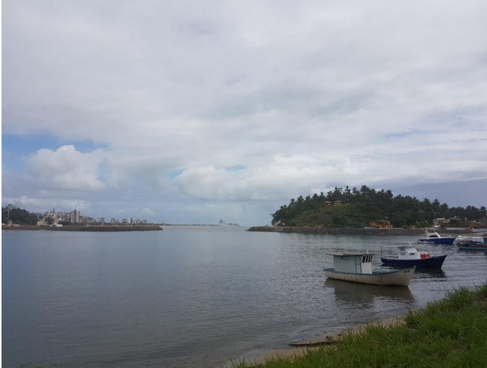
Figura 4 Foto de fevereiro/2017 do local das obras de construção da ponte, já é possível visualizar o aterro.
