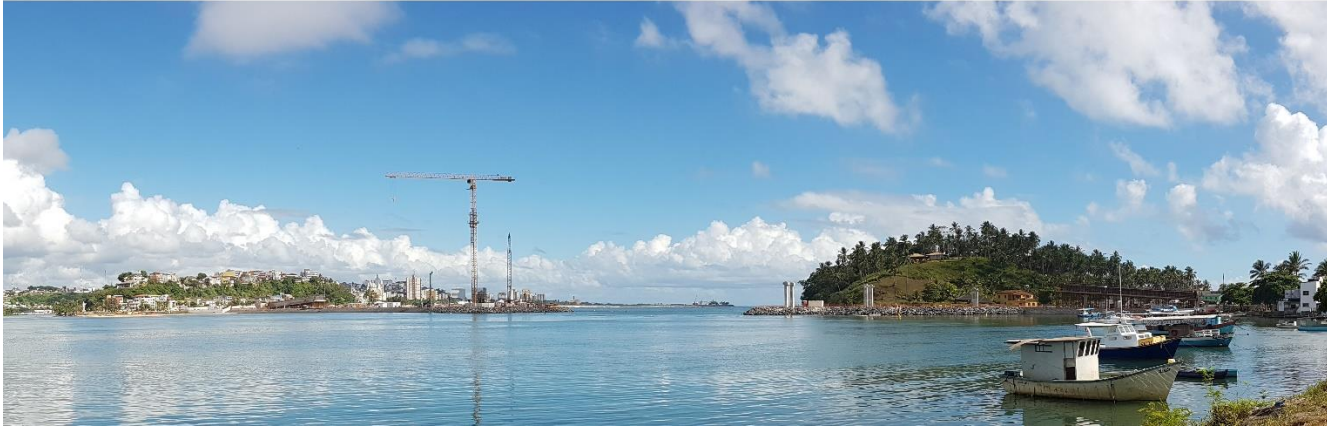
Figura 6 Foto de janeiro/2018 início da construção do pilar central
