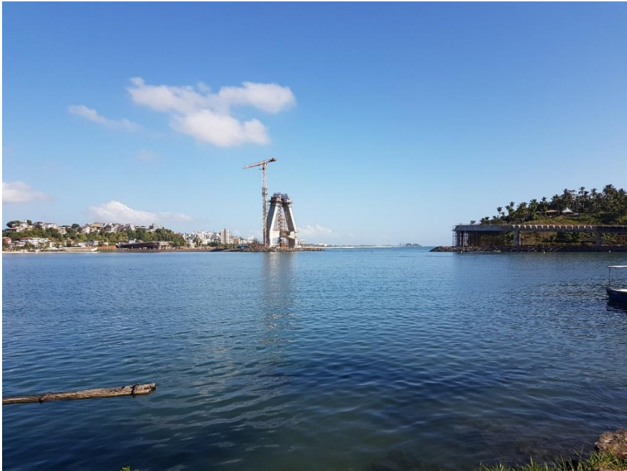
Figura 7 Foto de fevereiro/2019 – pilar central sendo concluído, e as vias de acesso iniciadas
